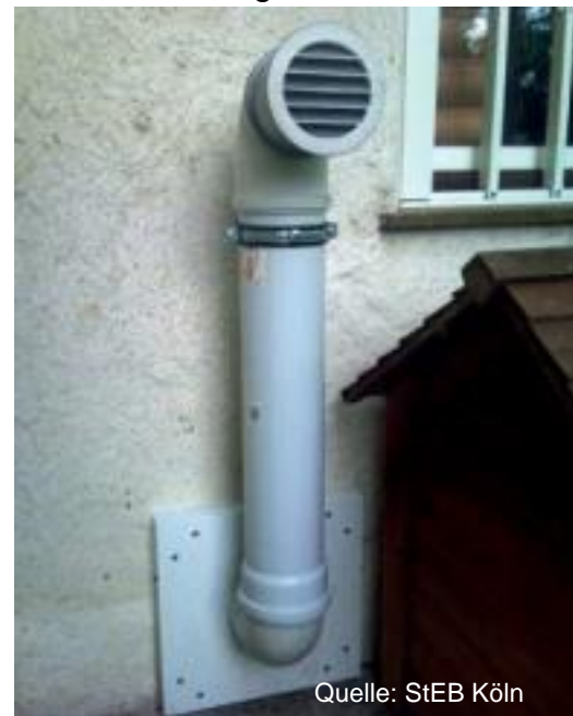
Erhöhte Lüftungen
