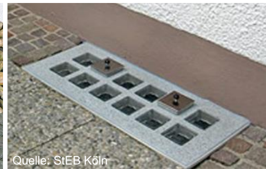
Abgedichteter Lichtschacht
